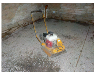
3 Uložení vedení odpadové kanalizace.
