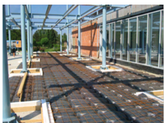
7 Položení tepelné izolace + dalších vrstev
