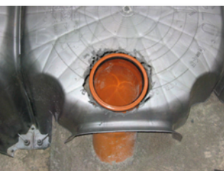
3 Uložení vedení odpadové kanalizace.
