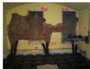
2 Příprava vyvedení odvětrávacích komínků z dutiny.
